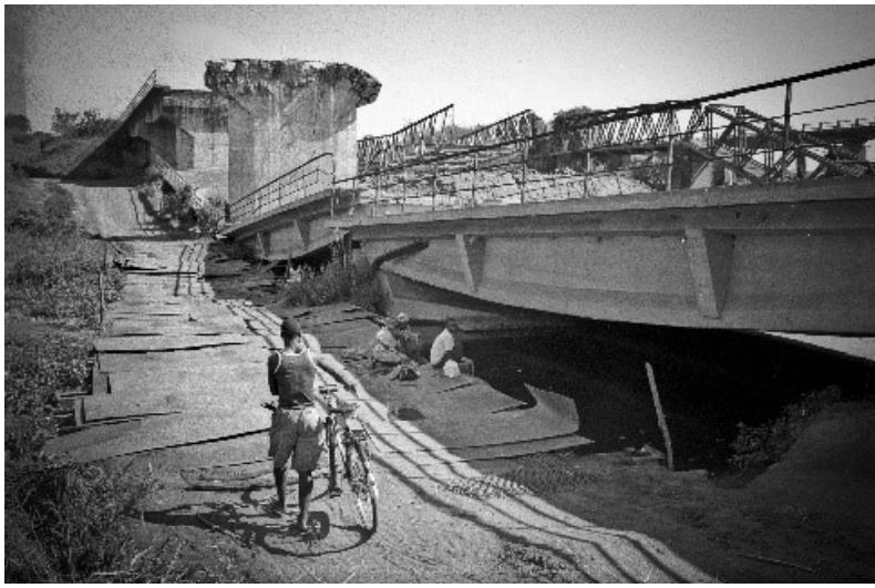
UN DES NOMBREUX PONTS DÉTRUITS DURANT LA GUERRE CIVILE AU MOZAMBIQUE
